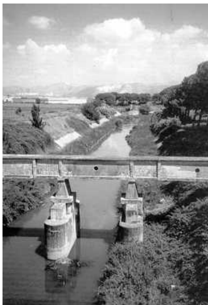
I Regi Lagni al confine tra Casapozzano e Marcianise
