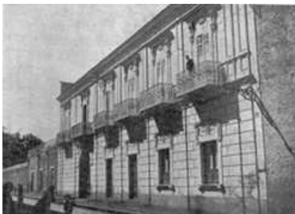
Esterno del palazzo sede dello stabilimento Pisano
