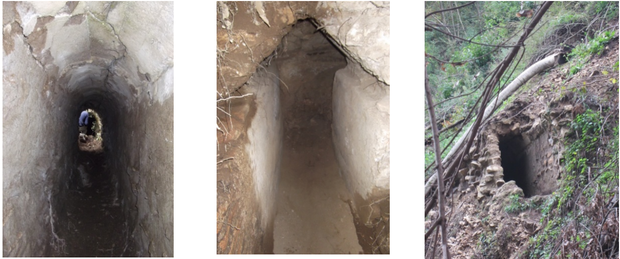
Fig. 2 - Resti dell'acquedotto nella zona di Cesinali.
