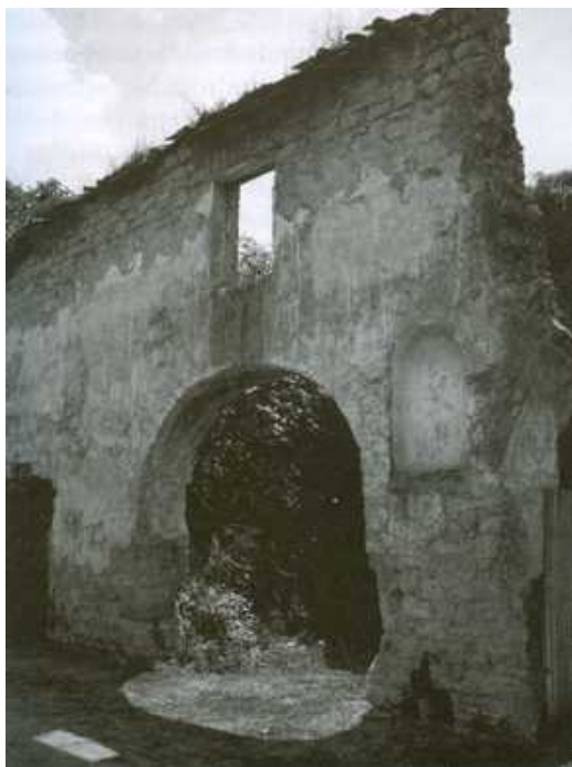
Casacella, la grancia. Particolare della corte
