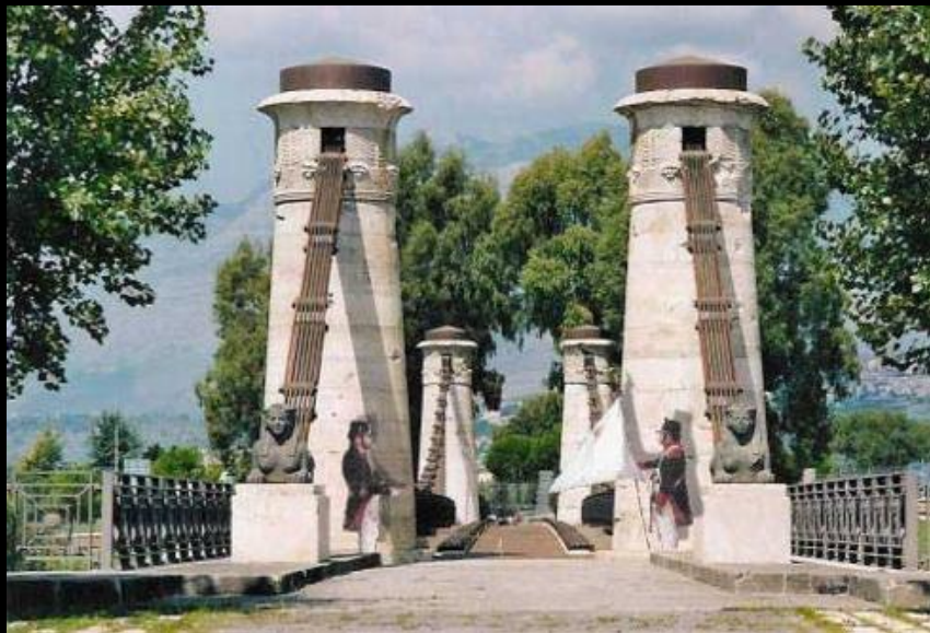
Il ponte pensile borbonico sul fiume Garigliano
