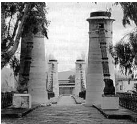
Il Ponte ricostruito
