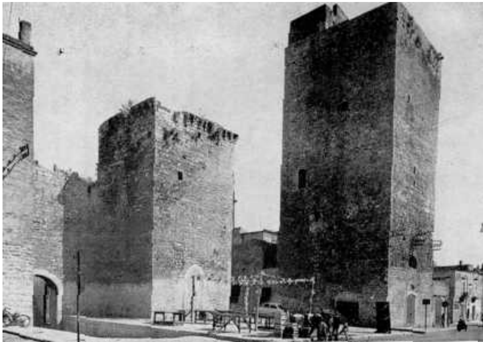
BISCEGLIE: Torre dei Normanni con i resti del Castello svevo.
