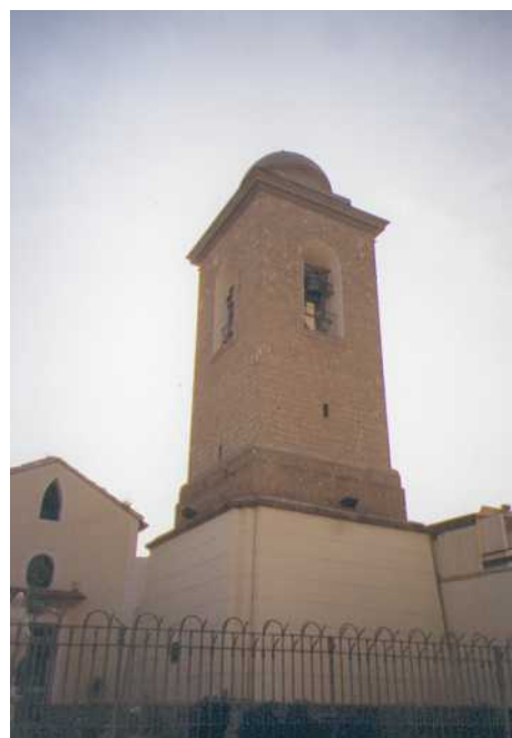
Torre campanaria della Chiesa di S. Gregorio Magno (via Lutrario)
