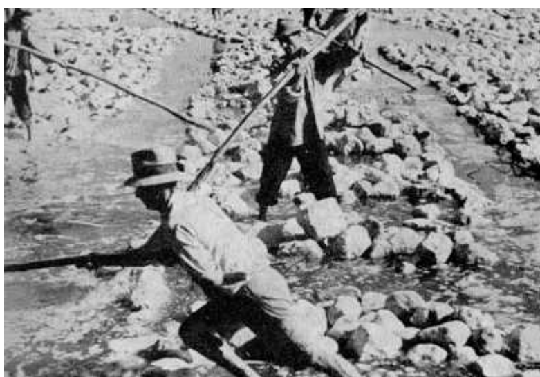
Spostamento di pile di canapa nella vasca di macerazione
