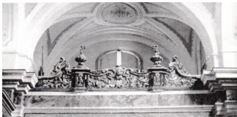
Fig. 5 - Interno della Chiesa: Corale
